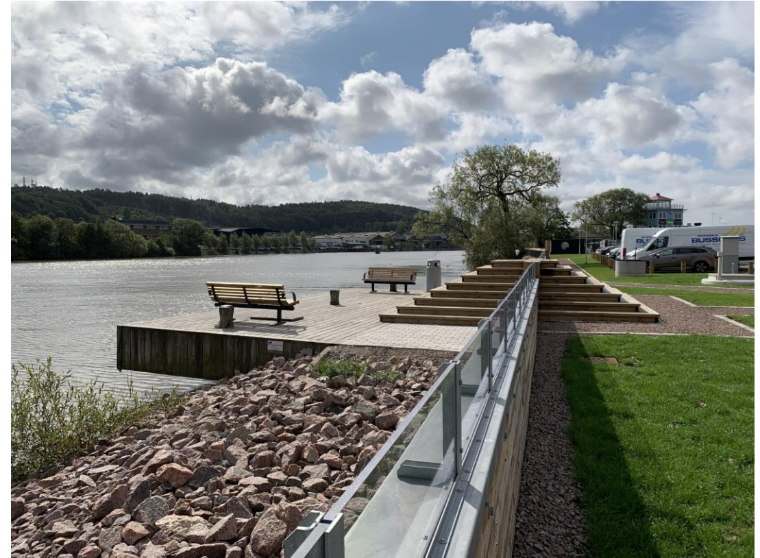
Byggt högvattenskydd i kombination med skredskydd vid Backa Bergö. Foto: Ytterbygg
