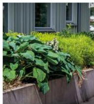
Upphöjd regnbädd kopplat till stupören.
